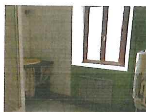
Salle d'eau carrelée 1 vasque, douche 5,1m 2
