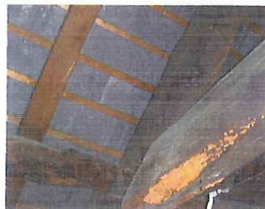
Toiture en ardoise amiante-ciment
