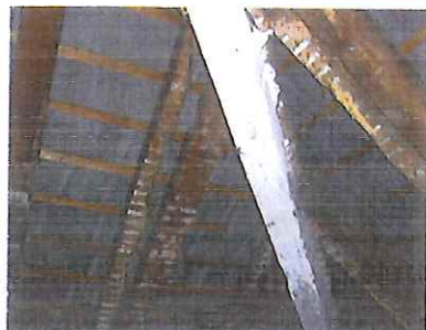
Toiture en ardoise amiante-ciment
